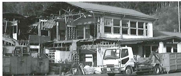
解体が進む旧役場庁舎(こども園建設予定地)
