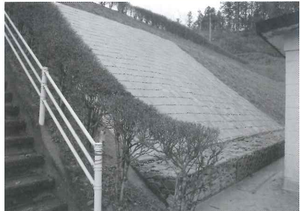
村民テニスコート施設災害復旧工事
