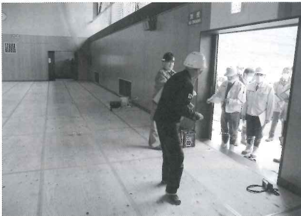
勤労者体育センター耐震改修工事
