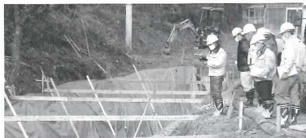
▲河川災害復旧工事(永田字石坪地内)
