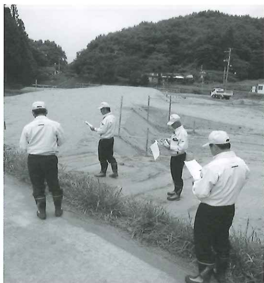
村道逆水論田線小平工区道路改良工事現場
